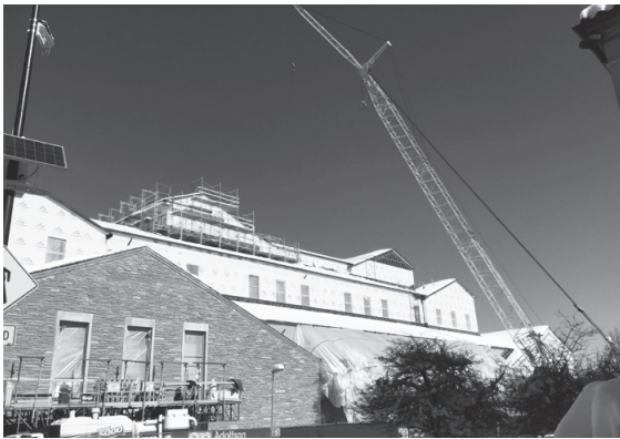
写真 38. ワーナー・マイケル音楽学科（建設中）
